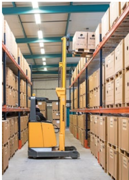
Entrepôt de Vourles (69), d'une surface de 2 500 m 2
